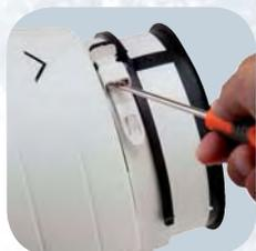
При помощи отвертки, ослабьте защелку.
