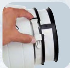
Установите корпус вентилятора обратно в монтажный кронштейн и закройте хомуты
